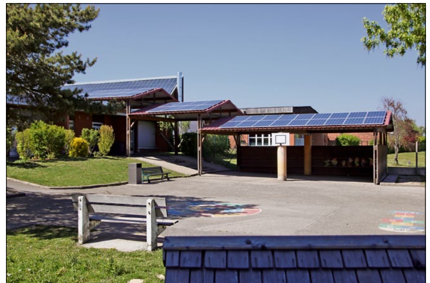
En matière de panneaux photovoltaïques, Ungersheim a construit un parc sur une friche industrielle, mais aussi équipé tous les bâtiments communaux.
